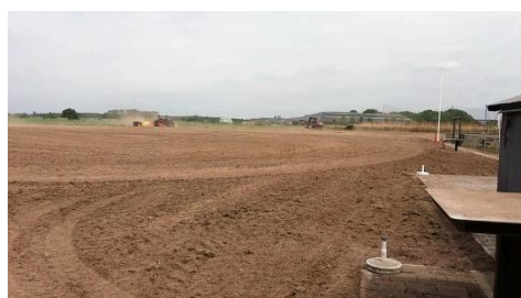
Het veld wordt eindelijk geëgaliseerd !
