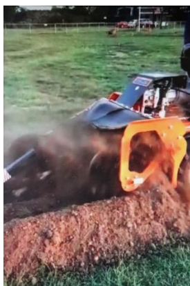
Sleuven graven met een gehuurde sleufgraafmachine.
