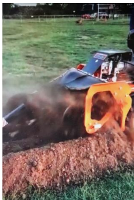
Sleuven graven met een gehuurde sleufgraafmachine.
