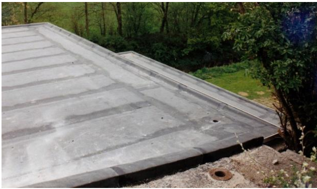
Een nieuwe dakbedekking, nu met isolatie eronder.
