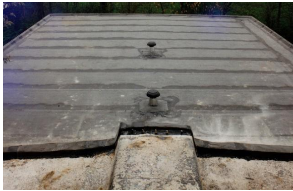
Een nieuwe dakbedekking, nu met isolatie eronder.
