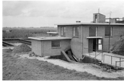
1945- 1975. Zij- en voorkant RIZI gebouw met links het pompgeaallhuis. Hier zitten boven nog ramen in de gevels (Zijn later dichtgemetseld).
