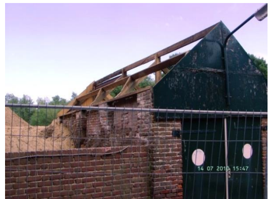
Het oude Maaihok aan de voorkant bij het clubgebouw wordt gesloopt.
