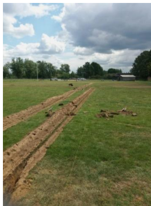
Sleuven graven met een gehuurde sleufgraafmachine.
