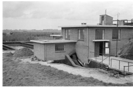
1945- 1975. Zij- en voorkant RIZI gebouw met links het pompgemaalhuis. Hier zitten boven nog ramen in de gevels (Zijn later dichtgemetseld).
