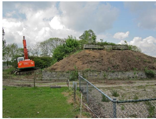
De aarden wal rondom de Buffertank en Gastank wordt afgegraven.
