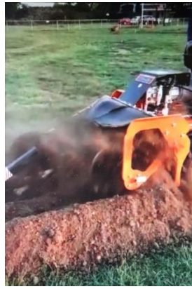
Sleuven graven met een gehuurde sleufgraafmachine.
