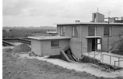
1945- 1975. Zij- en voorkant RIZI gebouw met links het pompgeaallhuis. Hier zitten boven nog ramen in de gevels (Zijn later dichtgemetseld).
