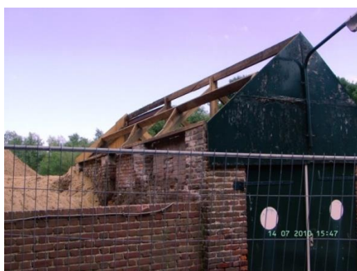
Het oude Maaihok aan de voorkant bij het clubgebouw wordt gesloopt.
