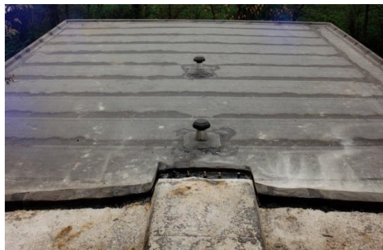
Een nieuwe dakbedekking, nu met isolatie eronder.
