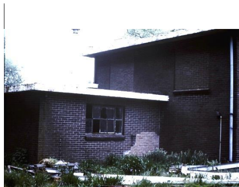
1978. Ik heb al menig gat hersteld en dichtgemetseld.
