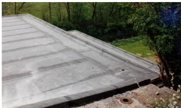
Een nieuwe dakbedekking, nu met isolatie eronder.
